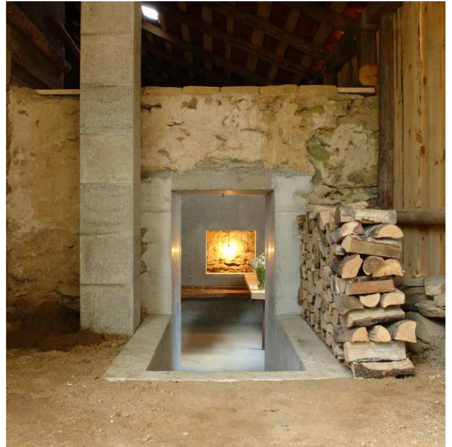
Der Eingang in die Küche
